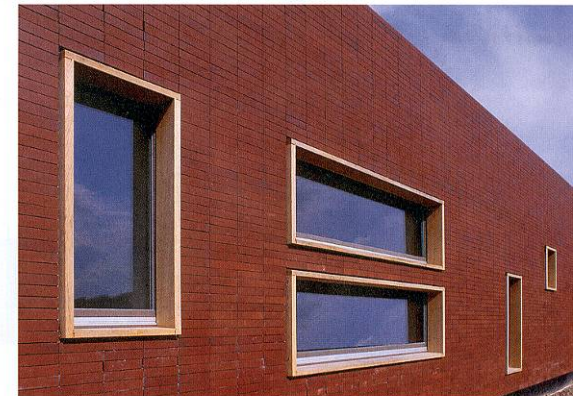
Kindertagesstätte Sternheimweg Hannover: Die Kreuzfugengeschichtete Klinkerwand wirkt durch das feinskalierte Fugenbild wie eine homogene Fläche.
