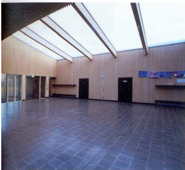
Vue du hall central. Le plafond est composé de coussins en membrane synthétique qui réduisent les risques de chutes et d'éclats en cas d'incendie
