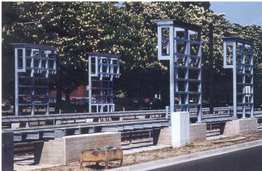
Feuerverzinkte Bahnsteig-Unterkonstruktion mit „P-Stützen“ während der Bauphase
